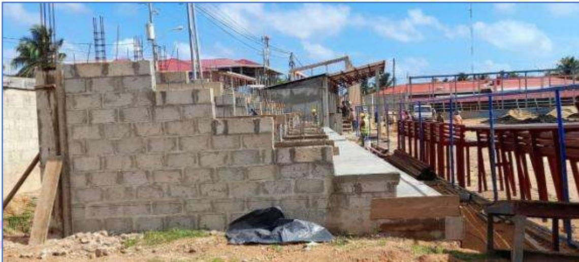
Gradas sol a nivel de fundicion con concreto de gradas reforzadas, esta se ubica en la linea de primera base.
