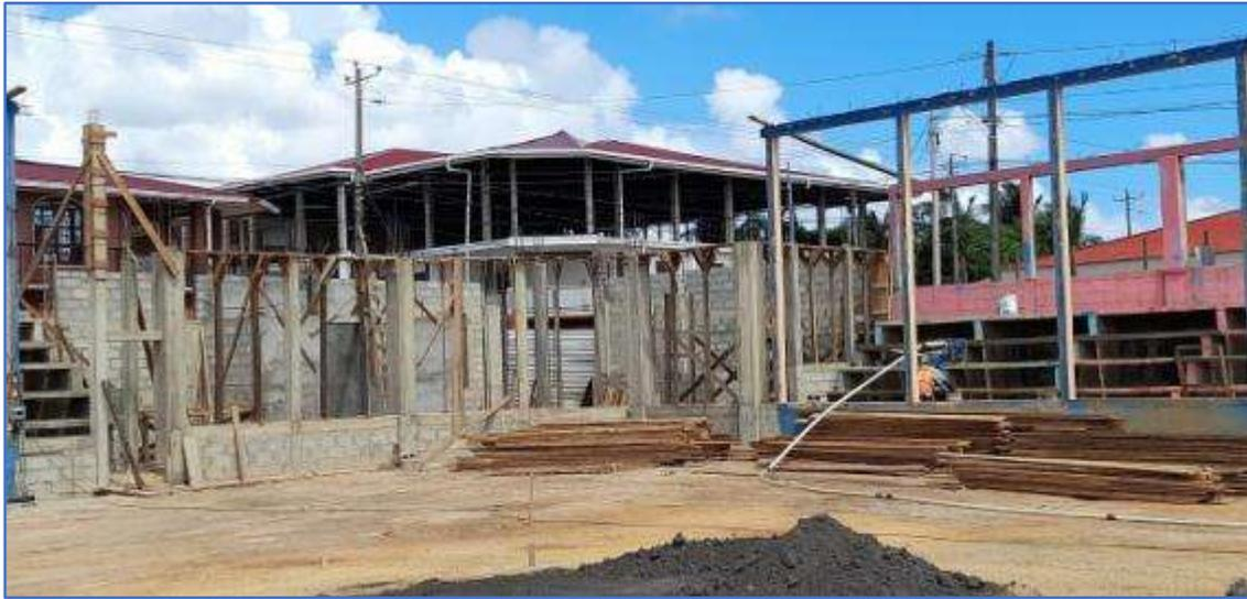
Area central del estadio apresiando las columnas de concreto que sportaran la losa de concreto.
